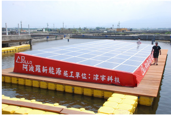
圖一 魚塢上的「浮力型太陽光電示範系統」 2
