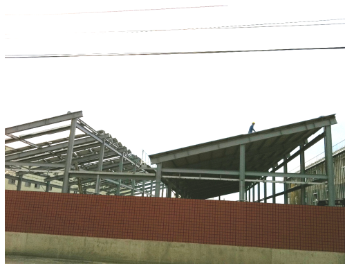
圖二、施工中的高架型太陽能發電系統(作者攝於 2011 年 8 月)
